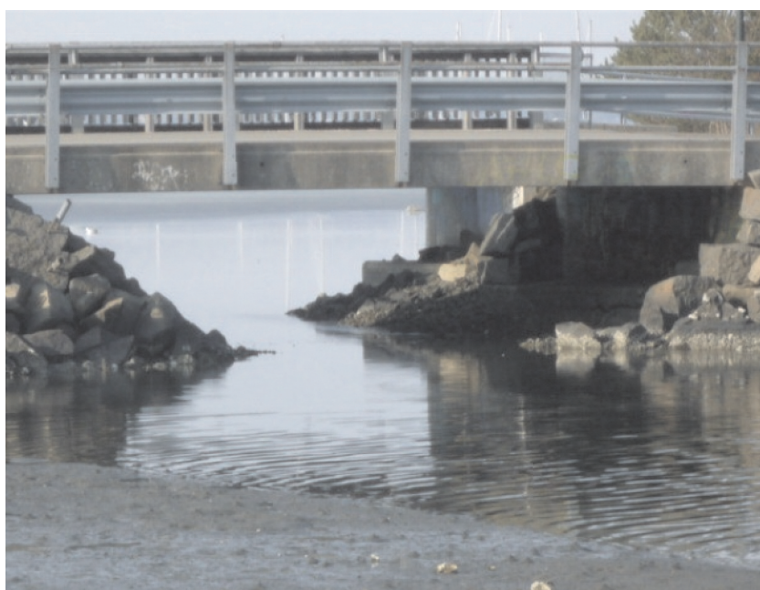
Moderat vannstand under Husøybroen. (Foto Jon Haffner)
